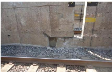
Junta abierta con deformación de muros y fuga de balasto en el P.K. 17+340 en el tramo Guelatao – Peñón viejo
