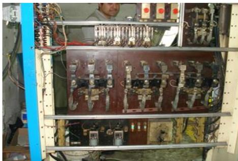
Tablero de control con término de vida útil y componentes obsoletos como son relevadores de sobrecarga, contactores, seguridades eléctricas, relevadores de fases, etc.
