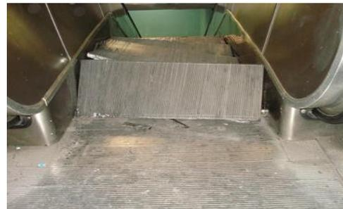
Choque de la escalera en la parte superior, debido a desajuste entre los escalones y la placa portapeines superior.
