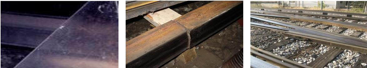
Desgaste en sección transversal del perfil de barra guía; fracturas de barra guía en soldaduras aluminotérmicas derivado de la fatiga y reducción de la sección transversal y durmientes en zona de aparatos de cambio de vía con alto grado de deterioro
