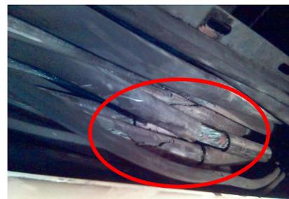
Cableado de alta tensión con aislamiento dañado
