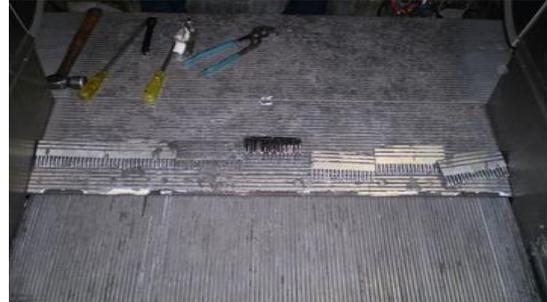
Placa portapeines con término de vida útil, en la estructura principal y en el perfil antiderrapante.
