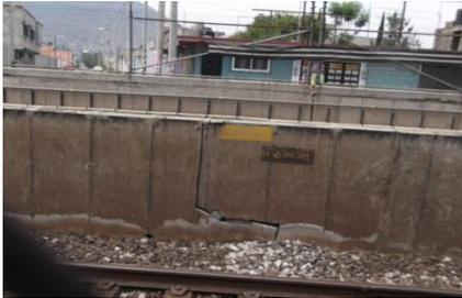
Junta cerrada sometida a esfuerzos de compresión en el P.K. 24+306 en el tramo Los Reyes – La Paz
