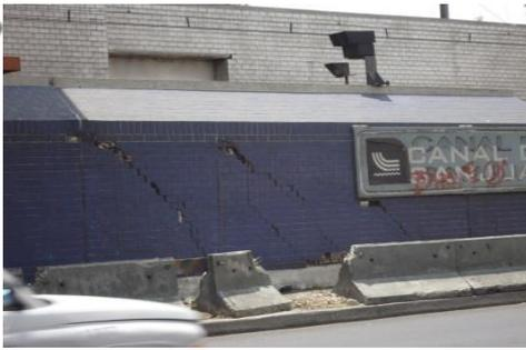
Daños estructurales en muros de estación
