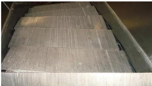
Rotura de escalones, debido a término de vida útil y obsolescencia de estos componentes.
