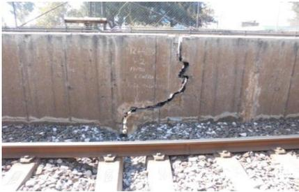
Falla estructural en muro en el P.K. 12+430, en el tramo Agrícola Oriental – Canal de San Juan
