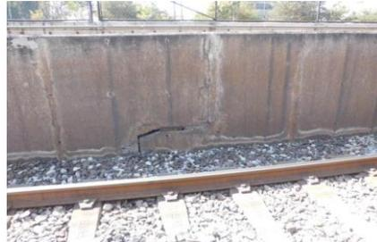
Junta cerrada sometida a esfuerzos de compresión en el P.K. 12+830 en el tramo Agrícola Oriental – Canal de San Juan
