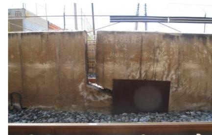
Junta abierta con deformación de muros y fuga de balasto en el P.K. 24+007 en el tramo Los Reyes – La Paz
