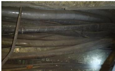
Cables de alta tensión obsoletos y envejecidos que propician fallas en los circuitos alimentadores de alumbrado y fuerza y subestaciones de rectificación, reduciendo la fiabilidad en la circulación de los trenes
