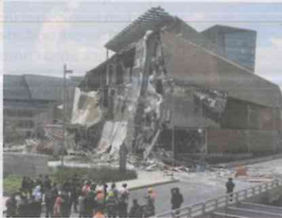
EL CENTRO comercial en Pedregal permanece clausurado y en revisión.
