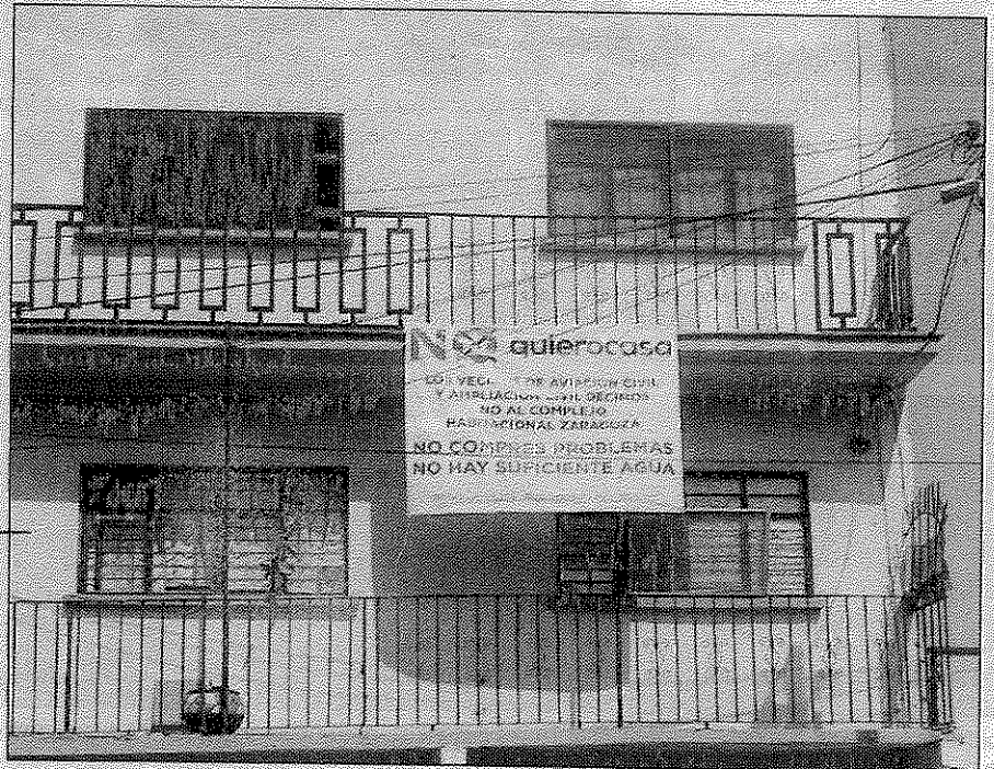
Vecinos de las colonias Aviación Civil y Ampliación Aviación Civil, en la Venustiano Carranza, piden frenar la construcción de un conjunto habitacional de 17 edificios de seis niveles para albergar 979 departamentos en calzada Zaragoza número 838 ■ Foto Rocio González Alvarado
