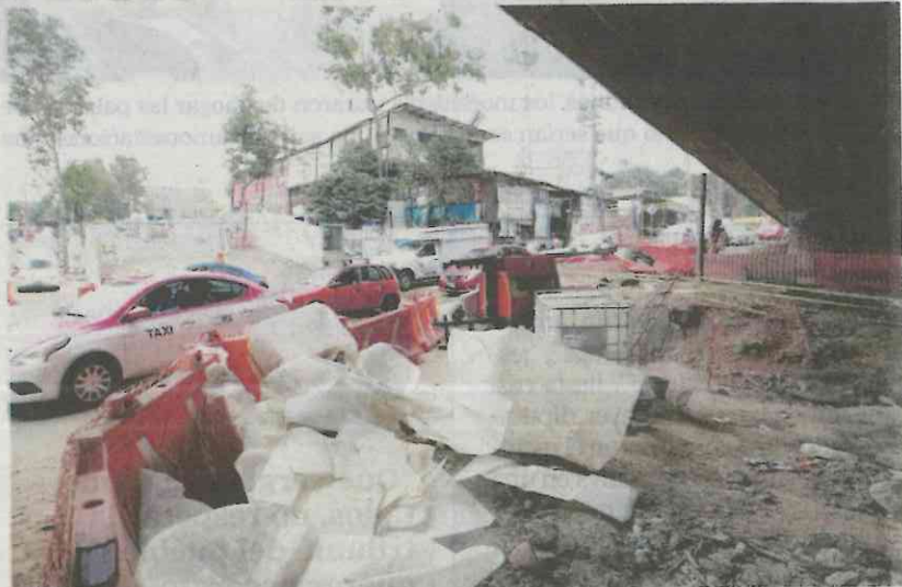
Hay varios frentes abiertos por los trabajos de ampliación de la Línea 12 del Metro; autoridades dicen que la excavación del túnel se concluyó.
