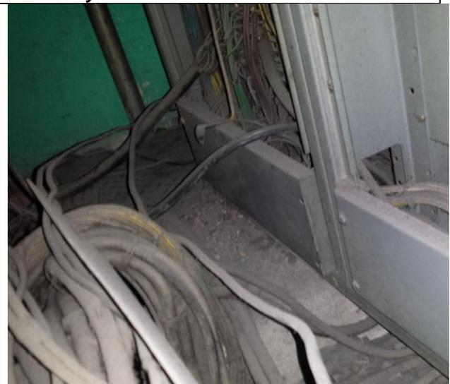
**Sustitución de los cableados de alimentación trifásica a 220 volts, más un hilo de tierra, desde la subestación eléctrica hasta el tablero de control y fuerza.**
