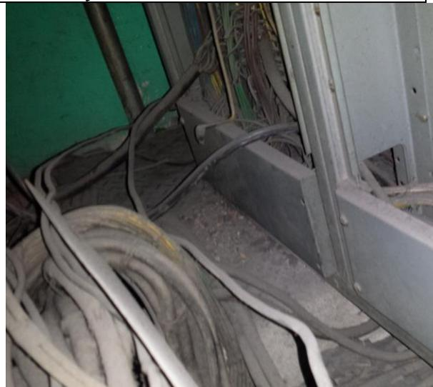
**Sustitución de los cableados de alimentación trifásica a 220 volts, más un hilo de tierra, desde la subestación eléctrica hasta el tablero de control y fuerza.**
