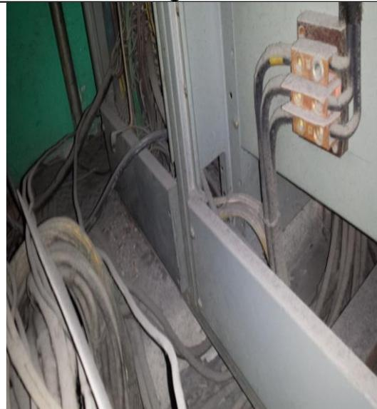
**Sustitución de los cableados de alimentación trifásica a 220 volts, más un hilo de tierra, desde la subestación eléctrica hasta el tablero de control y fuerza.**
