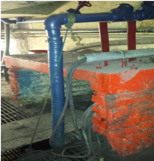
**Instalación de tubo conduit para alojar los cables de alimentación y control**
