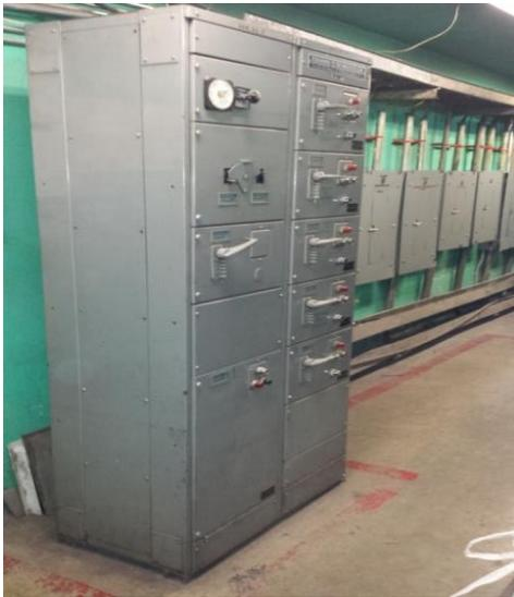
**Sustitución del centro de control de motores y transferencia automática en la subestación eléctrica, instalando un tablero de distribución en donde se encuentren todos los interruptores de los equipos de bombeo de la estación "TABLERO F", con alimentación PREFERENCIAL.**
