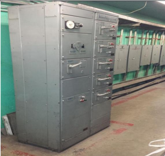
**Sustitución del centro de control de motores y transferencia automática en la subestación eléctrica, instalando un tablero de distribución en donde se encuentren todos los interruptores de los equipos de bombeo de la estación "TABLERO F", con alimentación PREFERENCIAL.**
