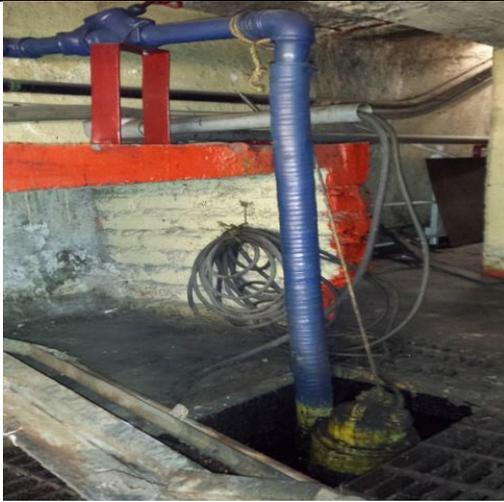
**Sustitución de: mangueras; soportes para tuberías de descarga y arreglo hidráulico; marcos y rejilla irving**
