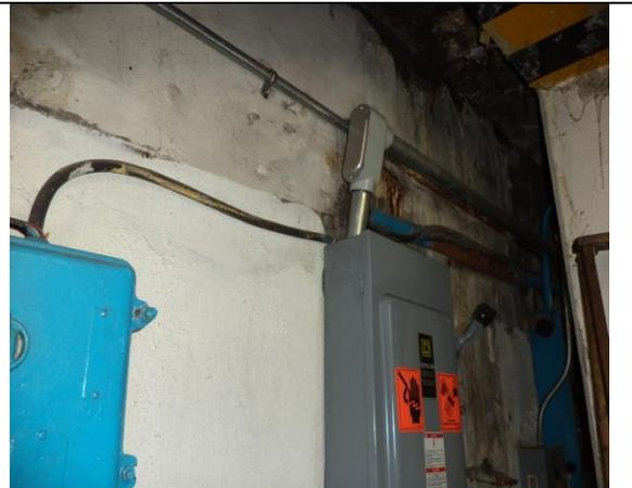
Sustitución de los cableados de alimentación trifásica a 220 volts, más un hilo de tierra, desde la subestación eléctrica hasta el tablero de control y fuerza.
