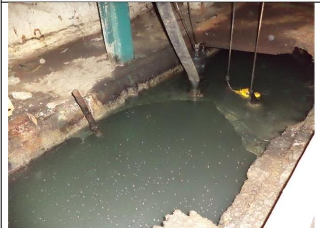
Sustitución de: mangueras; soportes para tuberías de descarga y arreglo hidráulico;
