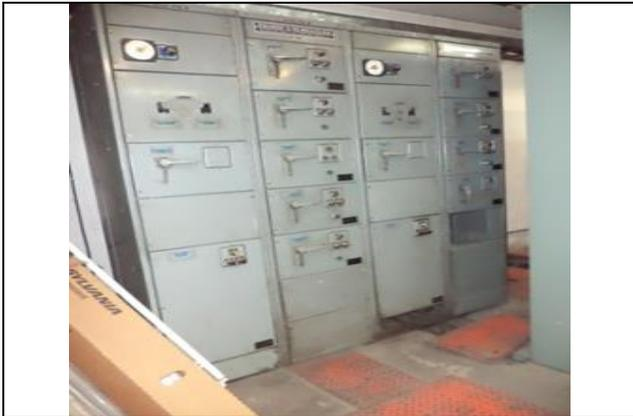
Sustitución del centro de control de motores y transferencia automática en la subestación eléctrica, instalando un tablero de distribución en donde se encuentren todos los interruptores de los equipos de bombeo de la estación "TABLERO F", con alimentación PREFERENCIAL.
