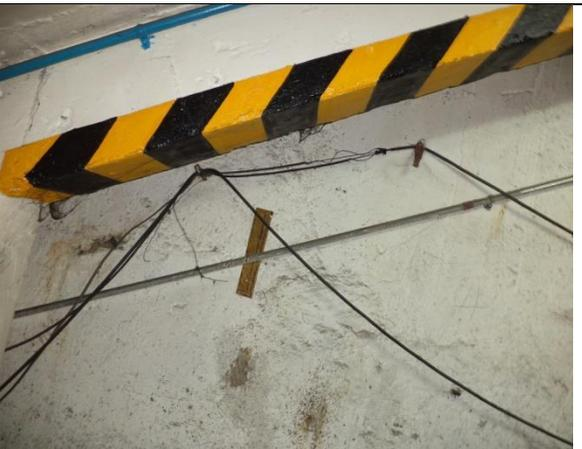
Instalación de tubo conduit para alojar los cables de control y fuerza
