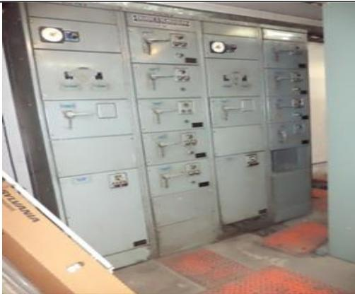
Sustitución del centro de control de motores y transferencia automática en la subestación eléctrica, instalando un tablero de distribución en donde se encuentren todos los interruptores de los equipos de bombeo de la estación "TABLERO F", con alimentación PREFERENCIAL.
