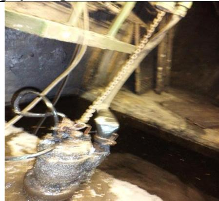
**Sustitución de: mangueras; soportes para tuberías de descarga y arreglo hidráulico; marcos y rejilla irving**
