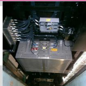
MÓDULO CHOPPER IGBT (Recuperación de energía)
