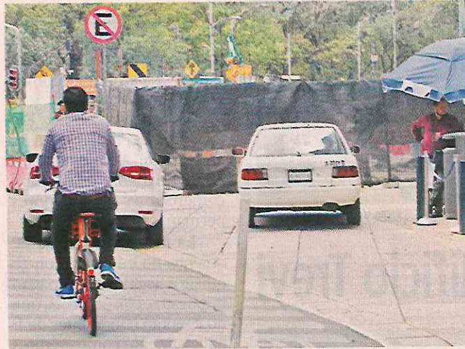
Los automotores que ahí se estacionan obstruyen la ciclovia.
