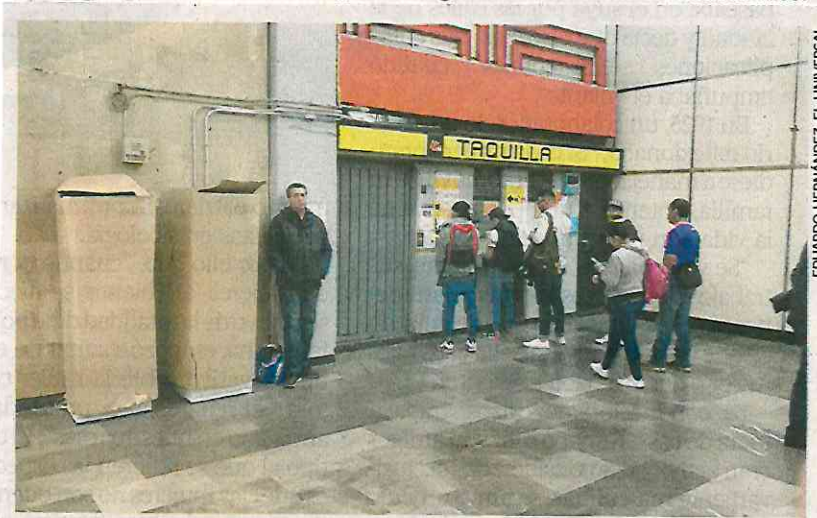
Los equipos se instalaron en las estaciones Pantitlán y Zócalo, aunque por el momento están cubiertas.
