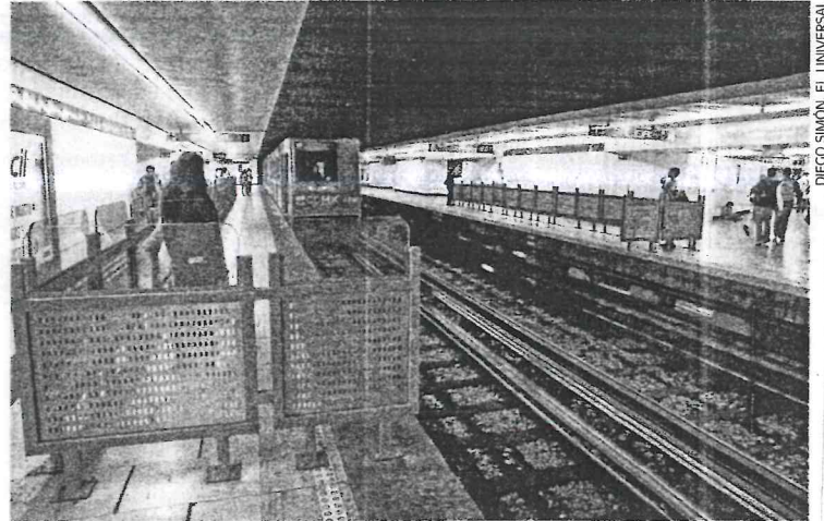
El informe del Fimetro asegura que los cambios en estos espacios sólo fueron estéticos y no se atendieron los problemas del cajón estructural.
