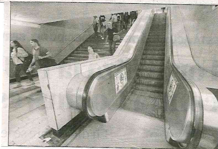
▲ Autoridades del Metro anunciaron la sustitución de escaleras eléctricas debido al vandalismo. Foto José Antonio López
